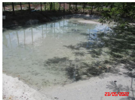
รูปที่ 2-14 บ่อดักตะกอนของโครงการ
